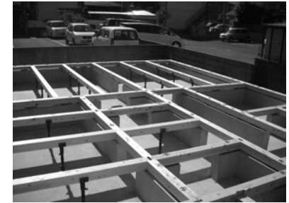
土台には国内産桧を使用しています。
