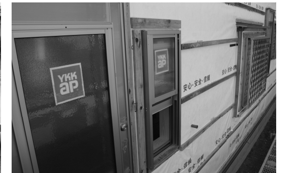
外壁下地は、通気工法で結露対策
